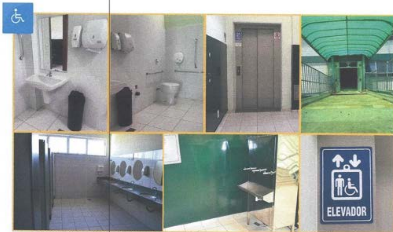
Figura: Acessibilidade elevador, banheiro para pessoas com deficiência, corrimão, rampa, bebedouro
